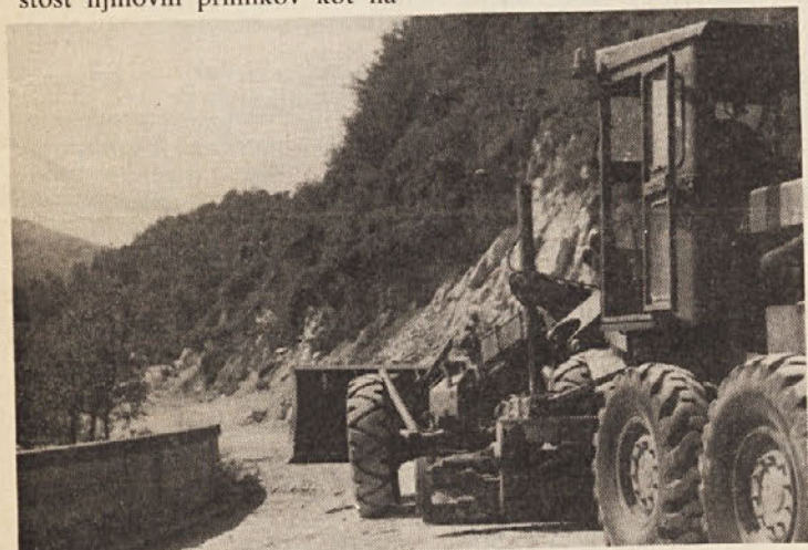
Gradbeni stroji JLA so v letu 1987 med prvimi pričeli »proboj« za sedanjo asfaltno cesto »življenja« na odseku Mitroviči–Osilnica. (Foto: J. Gorše.)
