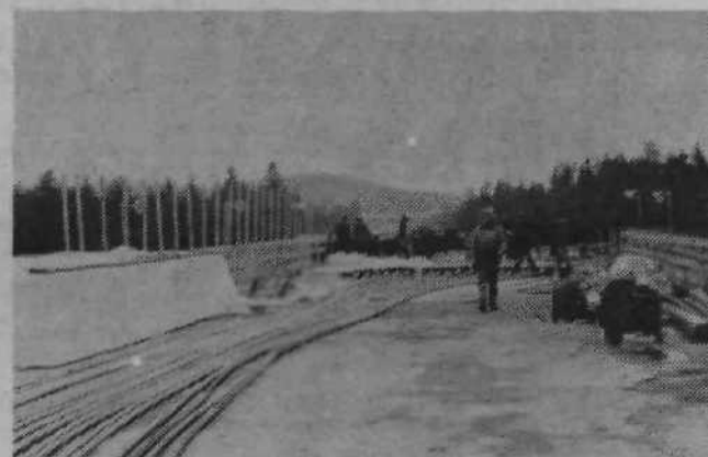
Tole je prvi posnetek z mostu, ki se za zdaj končuje še tik nad reko. Najprej bodo postavili polovico mostu, da bodo po njem lahko preko Save vozili gradbeni material. Delavci in gradnja ne poznajo počitka.
