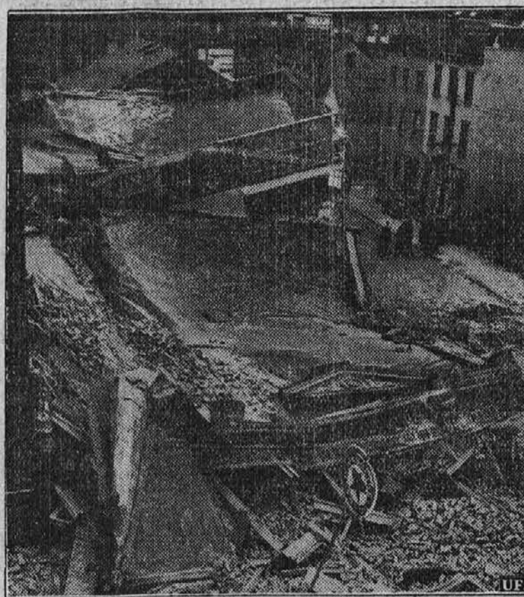
Razstrelba dinamita v mestu Waterford, je bila vzrok, da se je to poslopje porušilo v 10 milj oddaljenem mestu Troy, N. Y. Več oseb je dobilo pri tem težke poškodbe.
