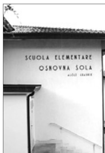
Šolska stavba v Števerjanu BUMBACA
