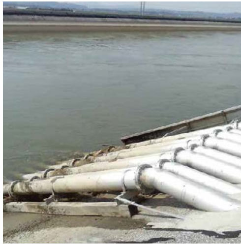
Slika 9: Prikaz zajema vode iz energetskega objekta HE Formin (vir: Priročnik za načrtovanje namakanja)
