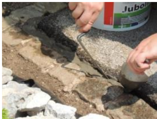
Slika 7: Fugiranje očiščenih špranj
