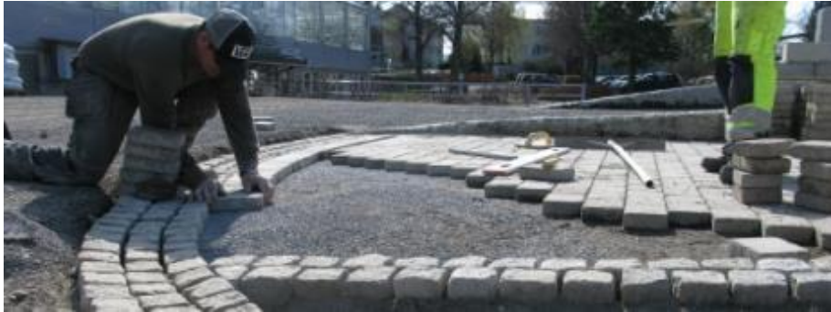
Slika 15: Prikaz tlakovanja predvidene površine vrtnarjev programa krajinsko vrtnarstvo
