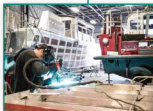
120 Izbira pravilnega dodatnega materiala za varjenje aluminija
