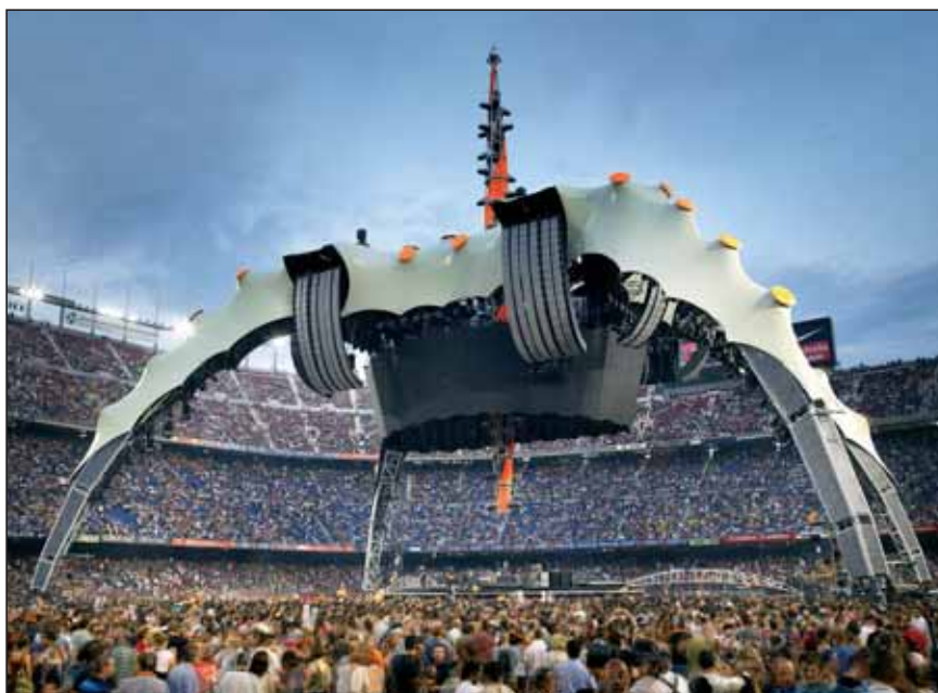
„Krepelj“, 30 m visoka odrska konstrukcija, ki omogoča publiki, da ima z vseh strani prost pogled na izvajalce na odru
