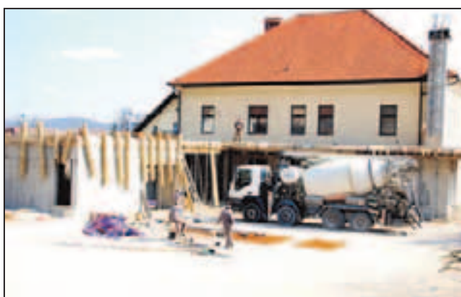
Gradbena dela na objektu ob Šolski cesti
