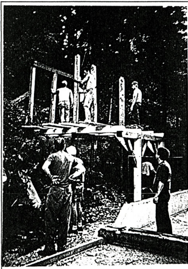
Za izgradnjo pomožnega objekta je bilo potrebnega veliko dela in materiala
