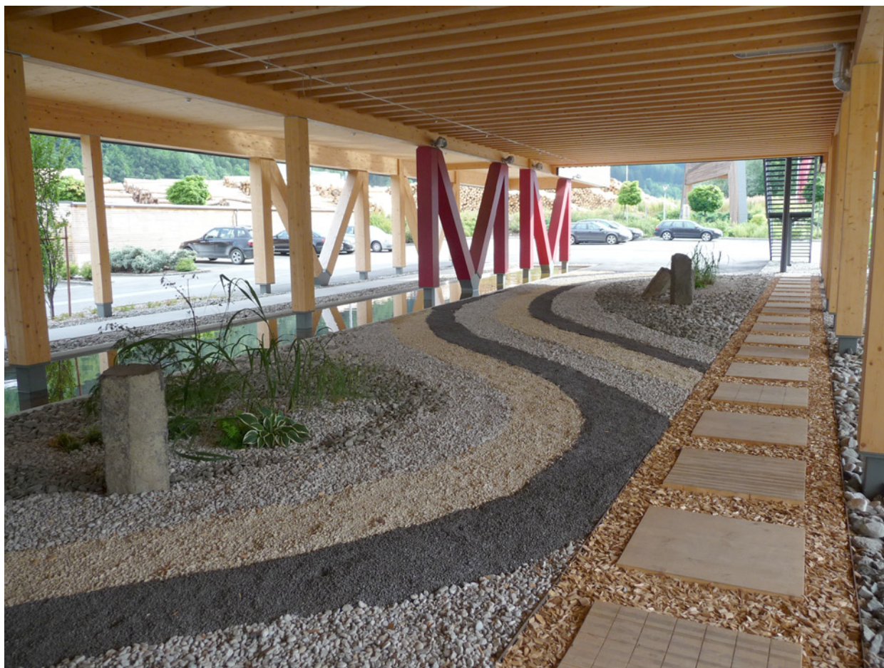
■ Slika 7. Nova centralna upravna zgradba enega največjih avstrijskih predelovalcev lesa podjetja Mayer-Melnhof v Leobnu. (foto: arhiv pro:Holz)
