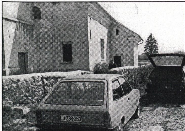
Ključar Janez si še zadnjič ogleduje cerkev v njeni stari "obleki". Čez kako uro bodo že stekla gradbena dela.
