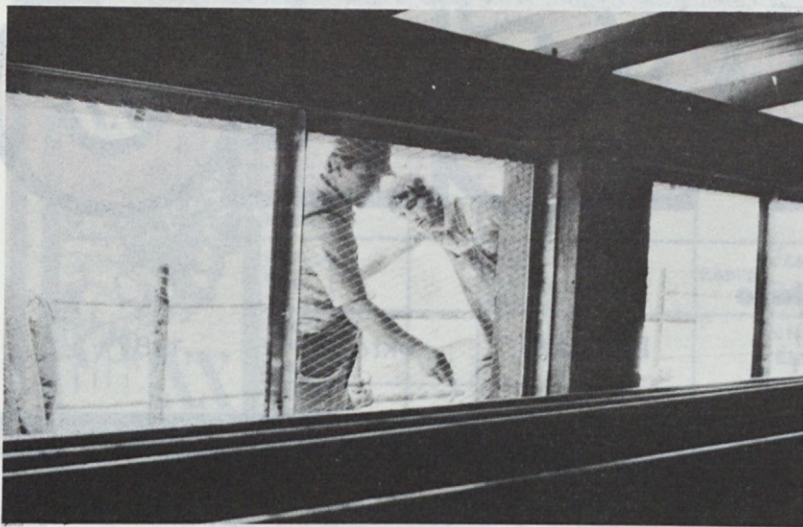
Delavci Gradisa pri zaključnih zidarskih delih za novo tovarno.
