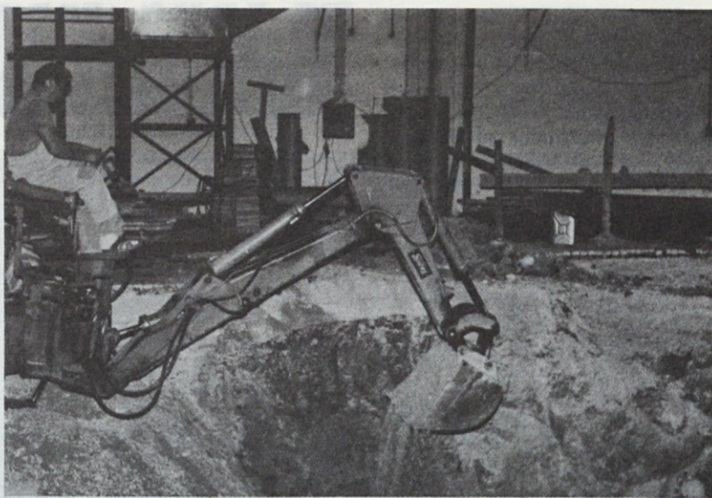
Priprava temeljev v tozdu Valkarton Logatec za montažo kartonskega stroja, ki bo izdeloval mikroval.
