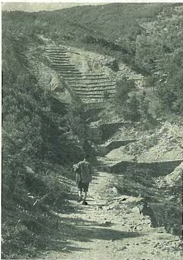
Tehniška in pogozdovalna dela so umirila nevarno flišno hudourniško področje v Sočergi (Istra)
