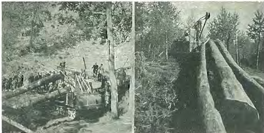
Levo: Motormuli z vitlom privlači in naklada hlode na poseki, kjer je blizu češke meje veter v gozdu povzročil veliko škodo. Desno: Motormuli izvlači hlode po terenu brez poti
