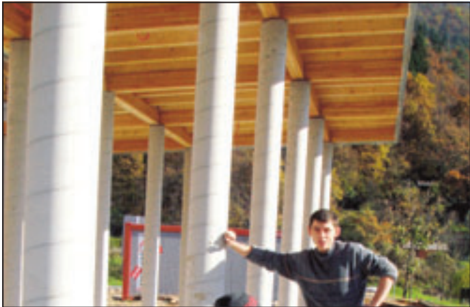
Mojstri na poslovnem objektu na borovniškem pokopališču opravljajo zaključna dela.
