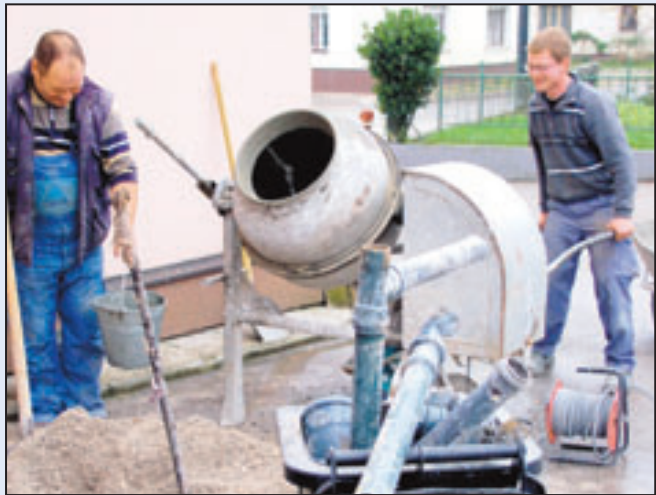
Gasilci pri betoniranju tal v sanitarijah
