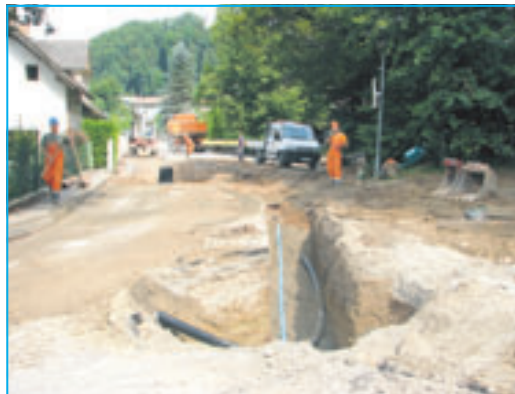
Poletje je bilo v znamenju asfaltiranja in obnove cestišč, v Dragomerju pa so gradili vodovod.
