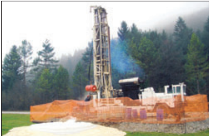
V Podstrmecu že izvajajo poskusne vrtine za rezervni vodni vir.
