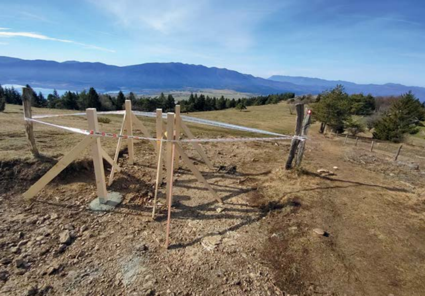
Postavitev tramičkov Foto Štefka Šebalj Mikše
