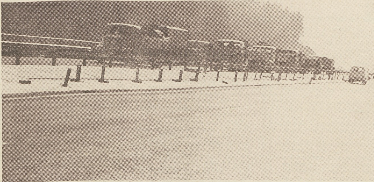
Preizkušnja mostu na Ravbarkomandi — Več kot 30 naloženih tovornjakov je preskušalo obtežbo mostu
