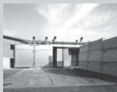
□ Slika 2. Na željo kupca so sušilne naprave za sušenje iglavcev izdelane za nakladanje prek tirnic
