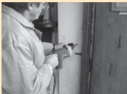
□ Slika 5. Vibracijsko vrtanje betona
