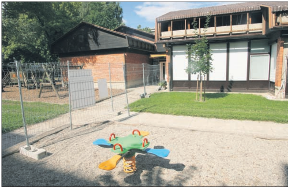
Inšpekcija za okolje in prostor je minuli teden ustavila dela v enoti Mavrica, dokler otroci ne bodo preseljeni na drugo lokacijo in ne bodo odpravljene ugotovljene pomanjklivosti. Ocenila je namreč, da obstaja možnost, da se bodo pri nadaljevanju odstranjevanja azbestnih plošč nad delom, kjer so igralnice, lahko sproščala azbestna vlakna, ki lahko ogrozijo zdravje otrok.
