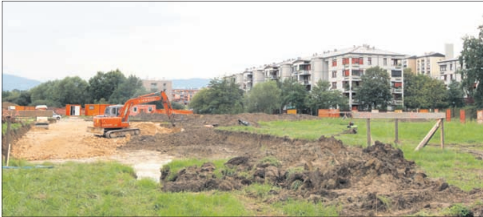
Konstruktorjevi stroji bodo hrumeli le še toliko, da ustrezno pripravijo gradbišče predvidenega vrtca v Novi vasi na prihod novega izvajalca del.
