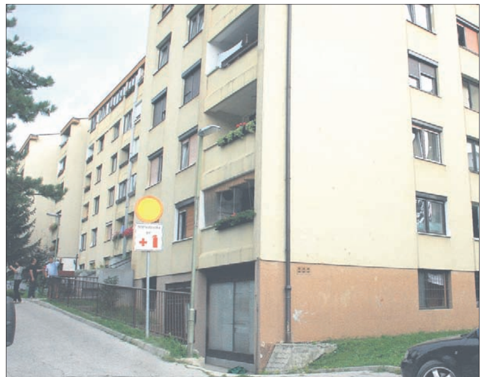
Od ograje na levi do konca rjavo pobarvanega zidu, v notranjosti pa je ostalo le pogorišče.
