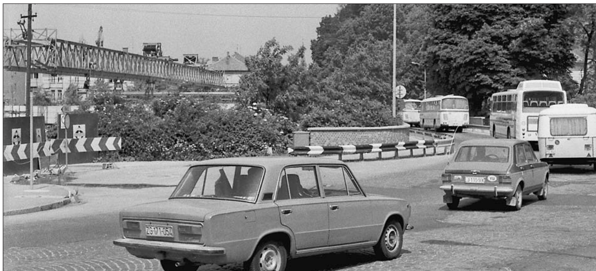
Zgoščen promet na starem Karlovškem mostu, na levi pa je vidno, kako napreduje gradnja novega mostu, junij 1977 (foto: Marjan Ciglič; hrani: Muzej novejšje zgodovine Slovenije).
