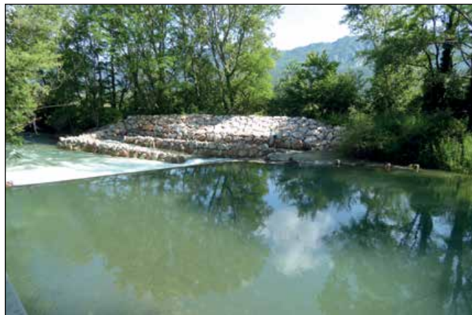
Ena izmed pregrad, ki omogočajo ribam prehod proti toku (Foto: Slavica Babič)
