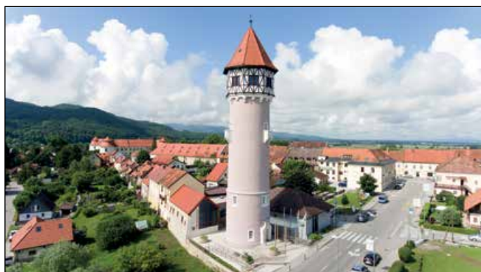
Brežice – vodovodni stolp
