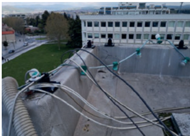
Slika 3: Nova smernica TSG-N-003 zahteva, da se v zapisniku o preverjanju morebitne odkrite neskladnosti tudi slikovno prikažejo oziroma dokažejo – primer levo: lovni vodnik na najvišjem delu stavbe premoščajo bakreni cevovodi plina in napajalni vodniki klimatskih naprav, kar je neustrezno in nevarno za vnos udarnega vala strele v objekt, slika desno: prenapetostni odvodniki, ki so odigrali svojo nalogo – indikatorji rdeče barve kažejo, da niso več uporabni
