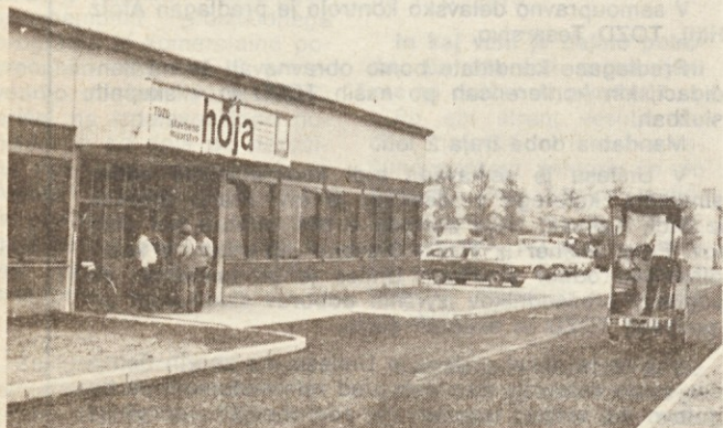
Težko pričakovana asfaltna prevleka v TOZD Stavbno mizarstvo
