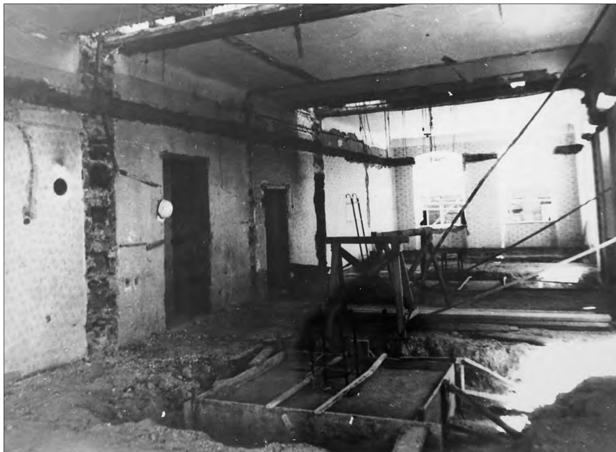
Notranjost prvega nadstropja nadomestne stavbe na lokaciji nekdanjega gradu (Gornji) Ljutomer med adaptacijskimi deli leta 1986 (gradivo stalne javne razstave fotografij v stavbi Podgradje 27).
