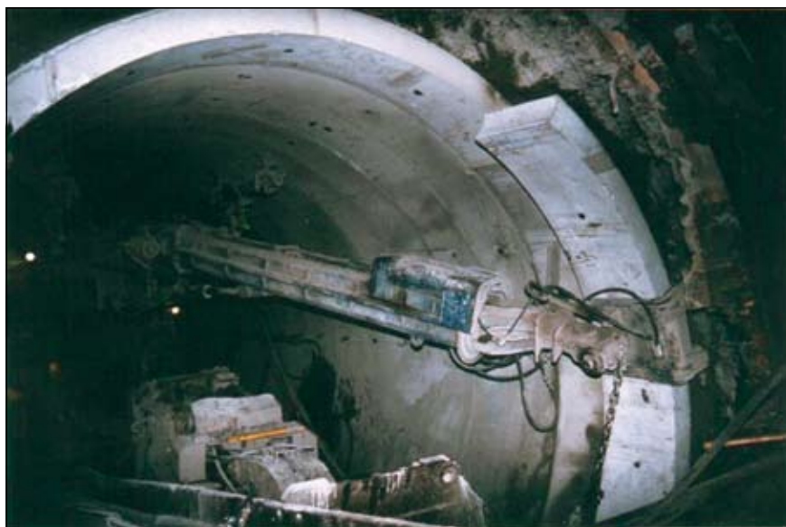
Slika 2. Podgradnja z betonskimi paneli
