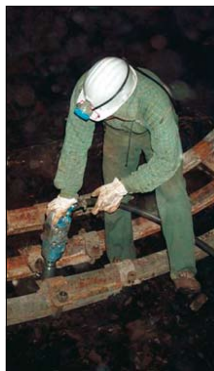
Slika 11. Vgradnja spodnjega dela ločnega podpora in zaključitev profila
