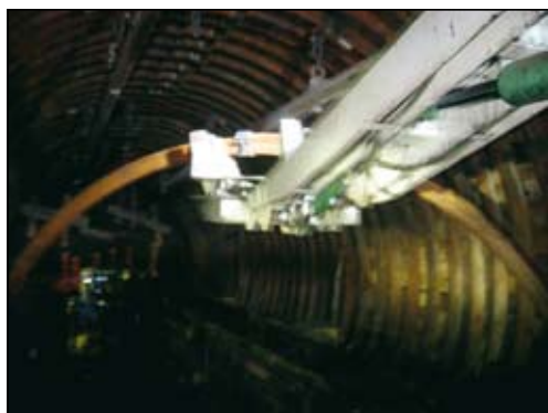
Slika 9. Transport in vgradnja ločnega podpora
