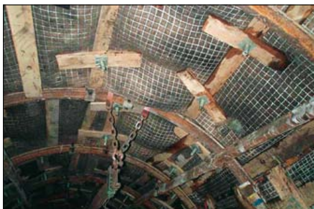
Slika 3. Podgradnja s kompozitnimi sidri in armaturno mrežo iz umetnih mas
