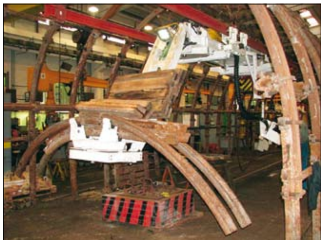
Slika 10. Transport potrebnega materiala na mesto vgradnje
