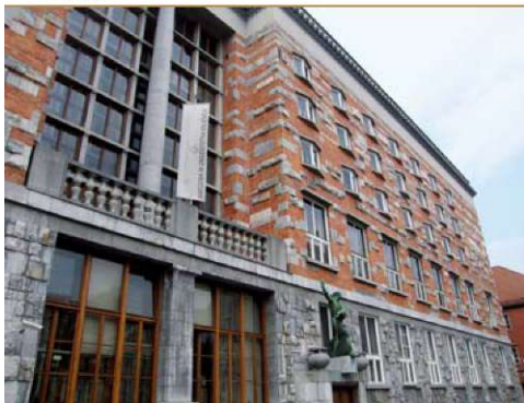
10. Ljubljana, Narodna in univerzitetna knjižnica, južna fasada pogled proti jugu 10. Ljubljana, National- und Universitätsbibliothek, Südflanke, Blick nach Süden
