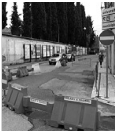
Gradbišče v Ulici Duca D'Aosta BUMBACA
