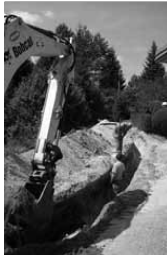
Obnova vodovoda v Zapotoku, Brezje
