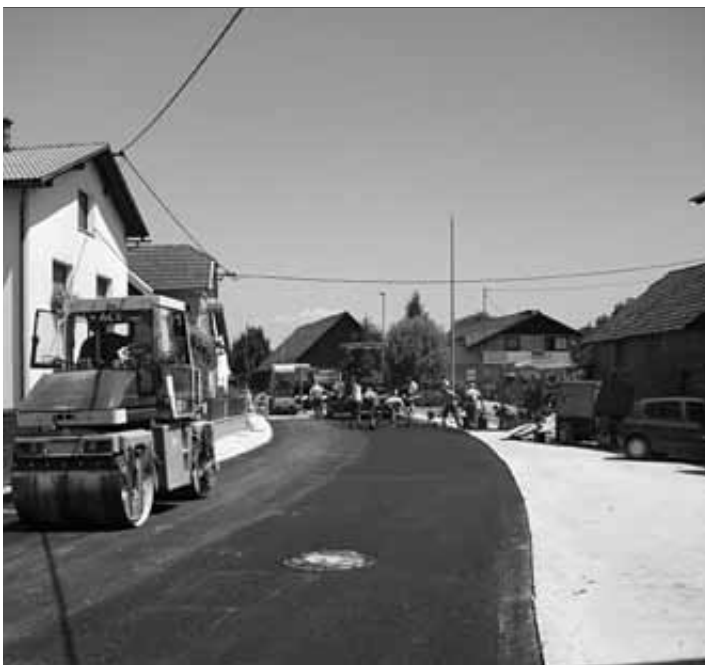
Asfaltiranje v Mateni po obnovi vodovoda in izgradnji kanalizacije
