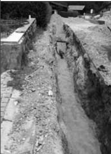
Obnova vodovoda v Zapotoku, Zaurbanca
