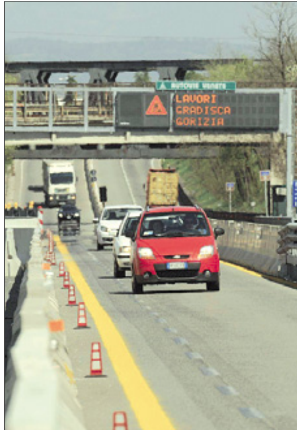
Gradbišče avtoceste Gorica-Vileš
