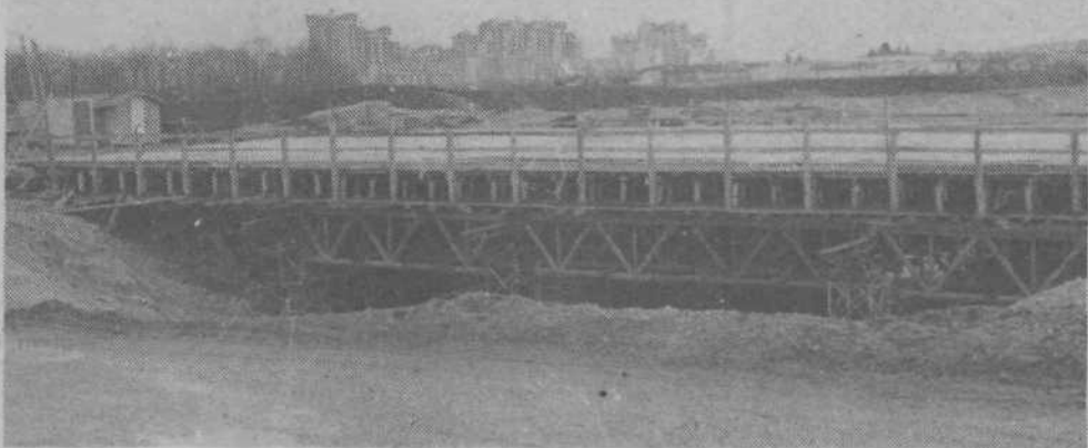
Nadvoz Saveljske ceste nad obvoznico je zabetoniran.
