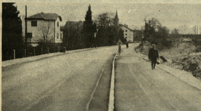
Posodobljena cesta in kolesarska steza
