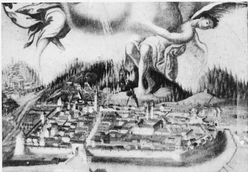
Celje koncem 18. stoletja. Takrat je gasil sv. Florijan nad oblaki, sedaj gasi požarna bramba brez angelske asistence. Pri prednjih vratih stoji zdaj Plečnikova stavba Ljudske posojilnice
