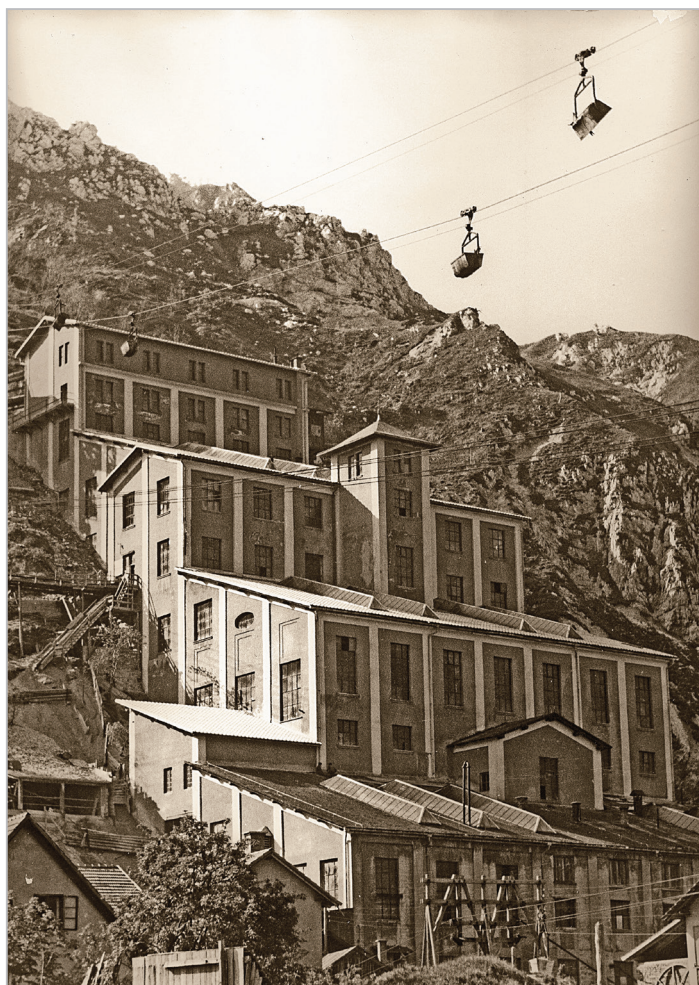
Stavba separacije rude v Žerjavu z žičnico za dovažanje rude iz jame in z degradirano okolico v ozadju (Koroški pokrajinski muzej)
