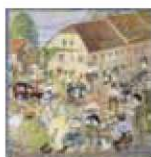
Flajštrajne v Ribnici, 1931, tempera, papir, 50 x 47.5, d. sp.: pin. J. Trošt 31, Muzej Ribnica, karikatura s prizorom tlakovanja ceste v Ribnici.
