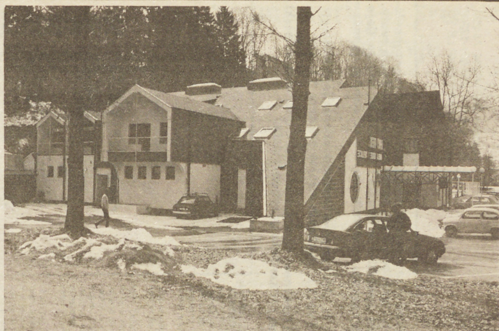
Objekt, pokrit z bitumensko skodlo.
