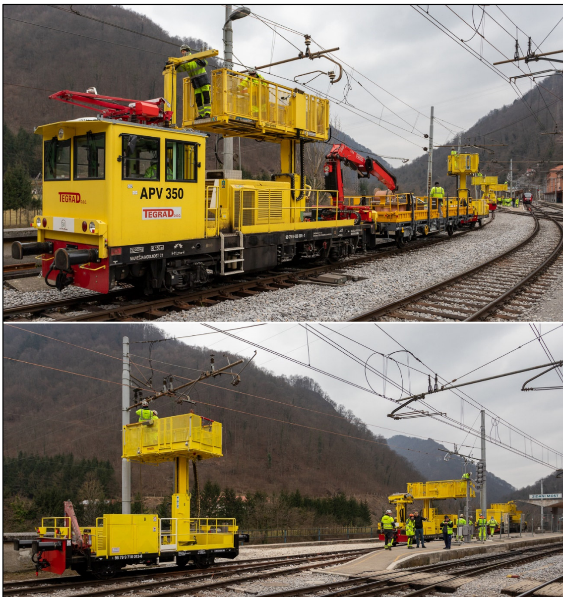
TMD Tegrad APV 350 in vagoni z dvižno platformo, 19. februar 2023 (avtor: Bojan Dremelj)
