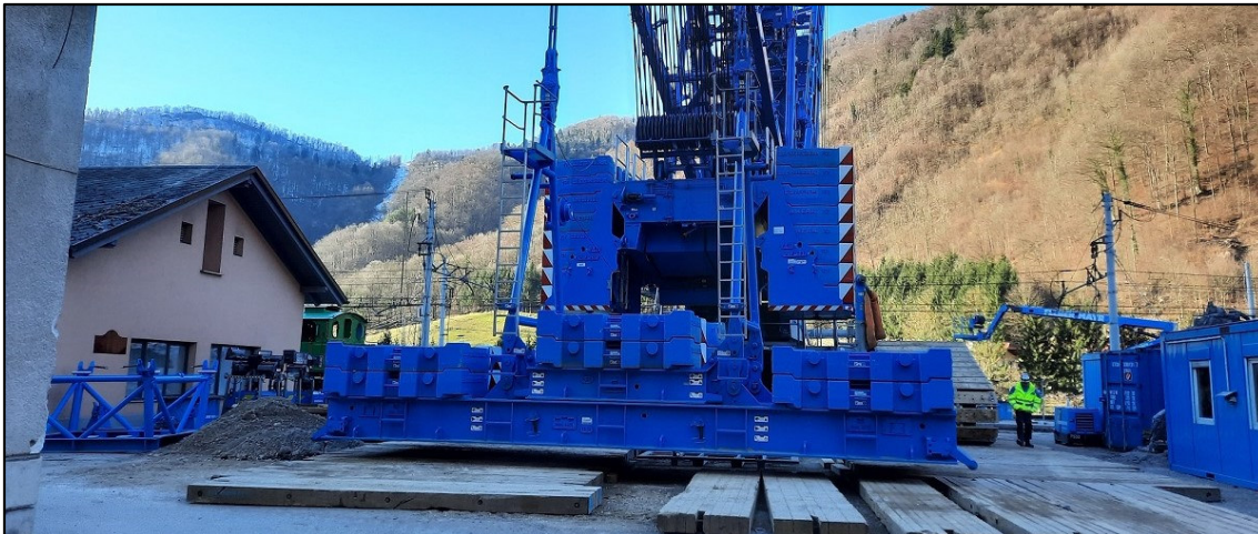
Viseča protiutež z maso \sim 140 t za rotacijo transformatorja (avtor: mag. Klemen Ponikvar)
