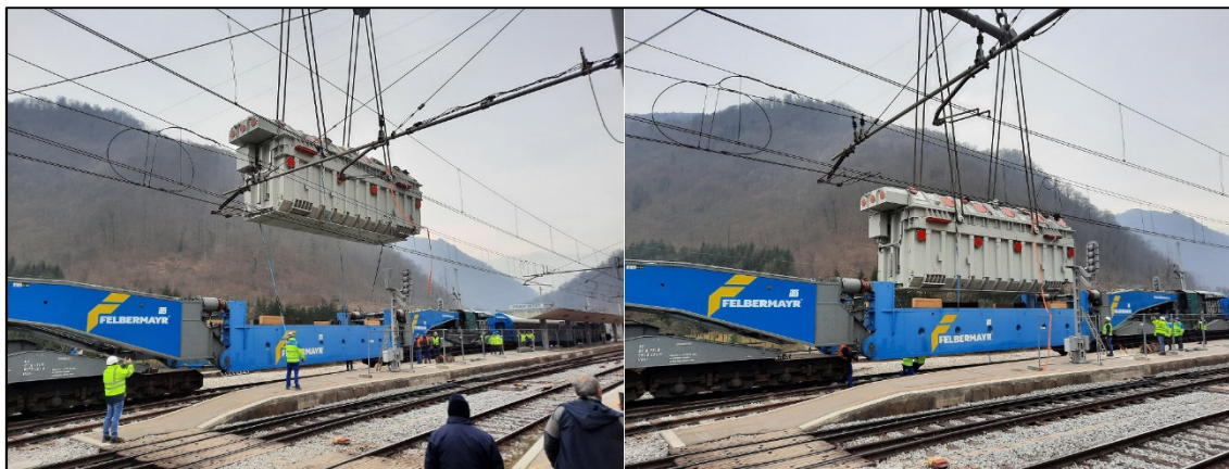
Spuščanje transformatorja med nosilni stranici, 18. februar 2023 (avtor: mag. Klemen Ponikvar)
