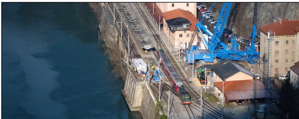
Vlak št. 2261 z EMG SŽ 312-125 in priprego SŽ 642, 2. februar 2023 (avtor: Bojan Dremelj)
