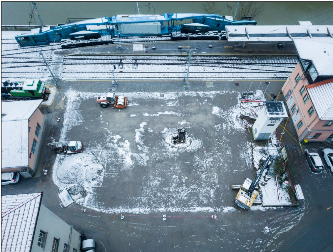
Pripravljena delovna ploščad, 16. januar 2023 (avtor: Bojan Dremelj)
