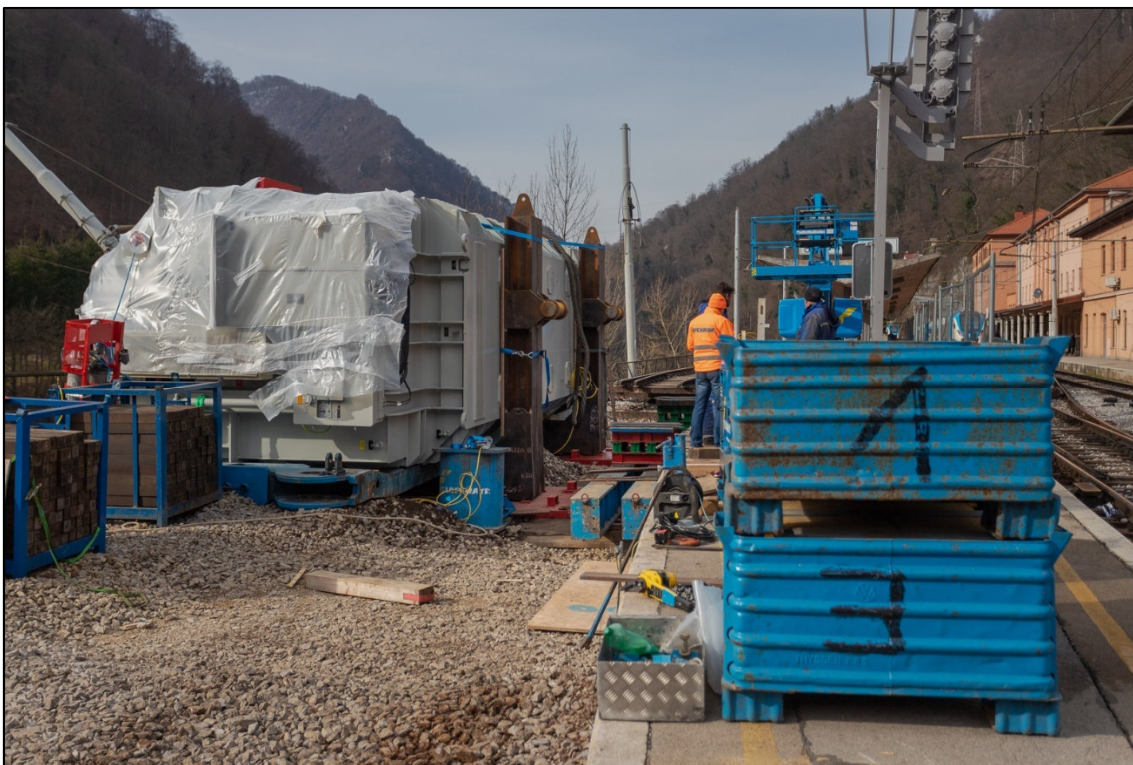
Postavitev jeklenih profilov za dvig transformatorja, 3. februar 2023 (avtor: Bojan Dremelj)
