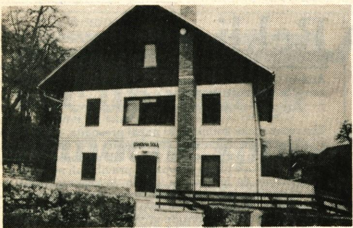
Stodvajset let stara šola, pred enajstimi leti s sodelovanjem krajanov temeljito obnovljena, je tudi zdaj lepa in urejena. Žal pa prostora v njej za normalen pouk ni...
