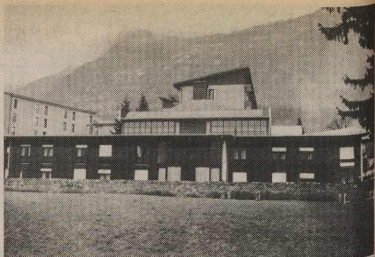
Alp hotel v Bovcu je dobil po obnovitvi in dograditvi dodatna ležišča in funkcionalnejše in kakovostnejše prostore.
