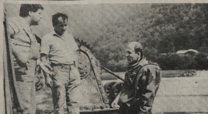
Graditi hidroenergetske objekte brez pomoči posebnih potapljačev je skoraj nemogoče. Tudi na Fali jih imajo štiri, na dan našega obiska pa je pod vodo delal Hasan Redžić.
