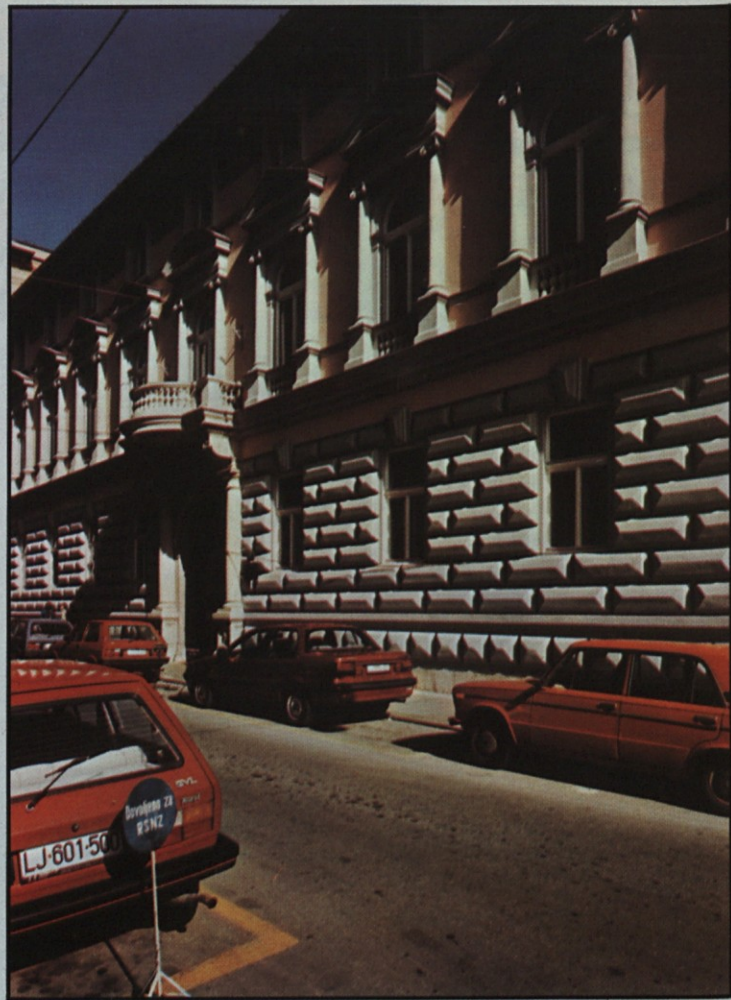
V zadnjem času so poleg novogradenj, ki jih je vse manj, zanimive tudi adaptacije. GP Ljubljana je obnovilo fasado ustavnega sodišča.
