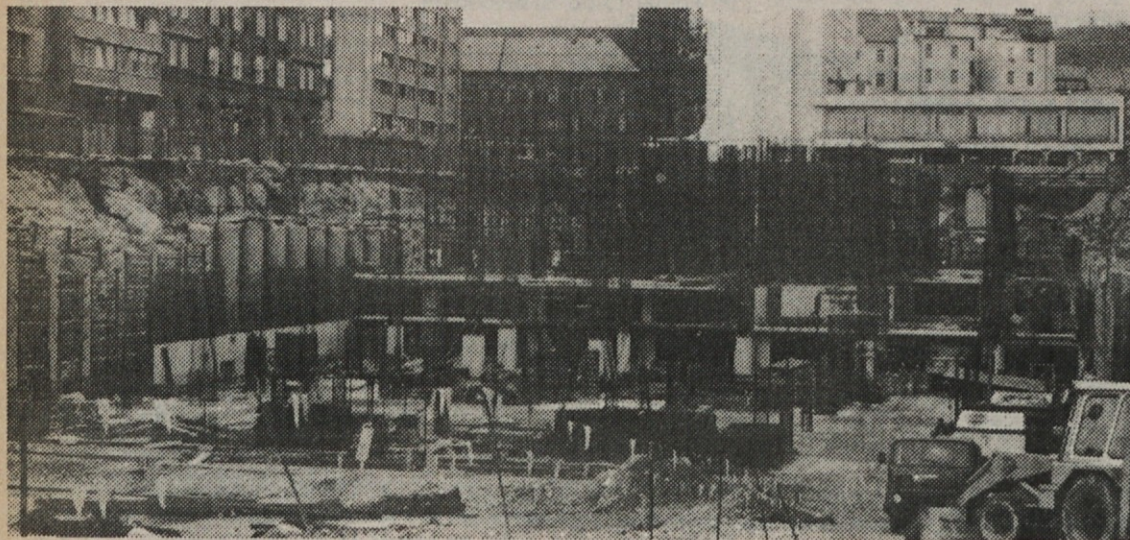
Delo v gradbeni jami pri hotelu Slavija, zaradi pomanjkanja sredstev za gradnjo, ne more zaživeti.
