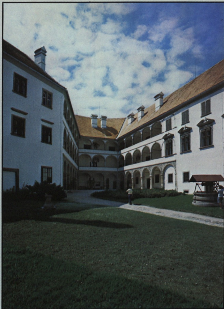
Ptujski grad že nekaj let zelo uspešno obnavljajo, z delom pa bodo nadaljevali tudi prihodnje leto, delavci GP Gradnje Ptuj.
