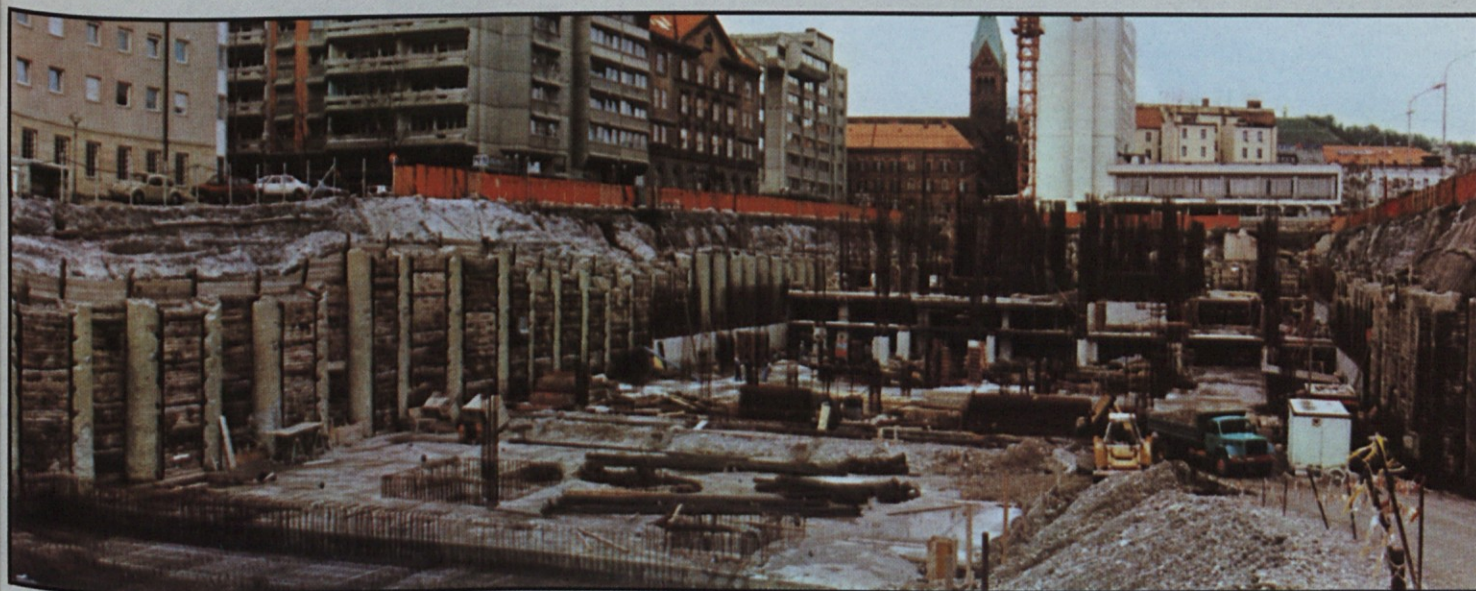
Gradbena jama v središču Maribora je postala, zaradi številnih zapletov, zelo znamenita. Spričo pomanjkanja sredstev se v jami dolgo časa ni delalo, sedaj pa gradbeniki iz GP Maribor vendarle upajo, da bo priliv denarja normalnejši in da bodo gradnjo garaž marca prihodnje leto končali.
