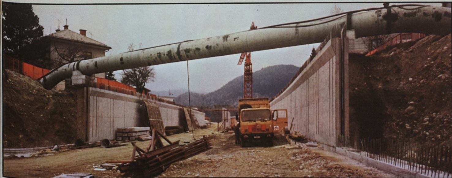
180 metrov dolgo galerijo oziroma pokriti vkop, na trasi avtoceste od Hrušice do Vrbe, gradijo delavci GP Nizke gradnje Maribor. V galerijo se bo vstopalo neposredno z viadukta Moste pri Žirovnici.
