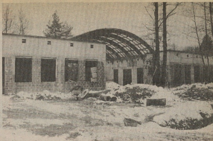
Vhod v botanični vrt je lepo vklopljen med obstoječe drevje.
