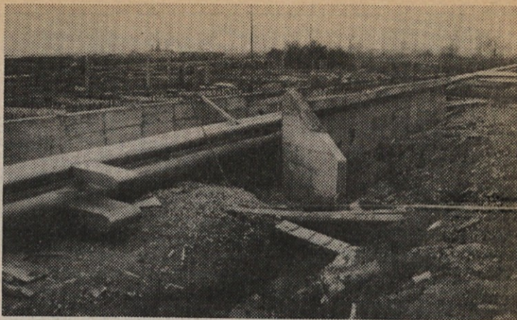
Gradnja vagonkega pretakališča za naftne derivate v Serminu.
