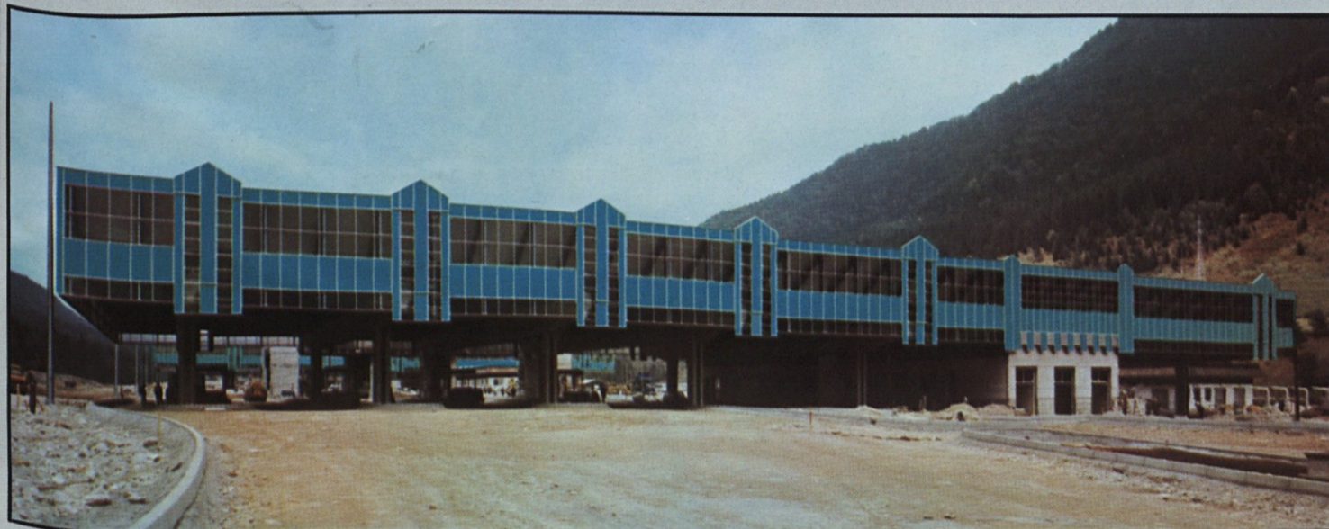
Letošnje največje Gradisovo gradbišče je bilo na Karavanškem mejnem platoju, kjer je GP Jesenice zgradilo več kot deset velikih objektov. Največja sta oba mejno-kontrolna objekta. Dolga sta vsak po 90 in široka po 75 metrov. Na fotografiji je jugoslovanski mejno-kontrolni kompleks.
