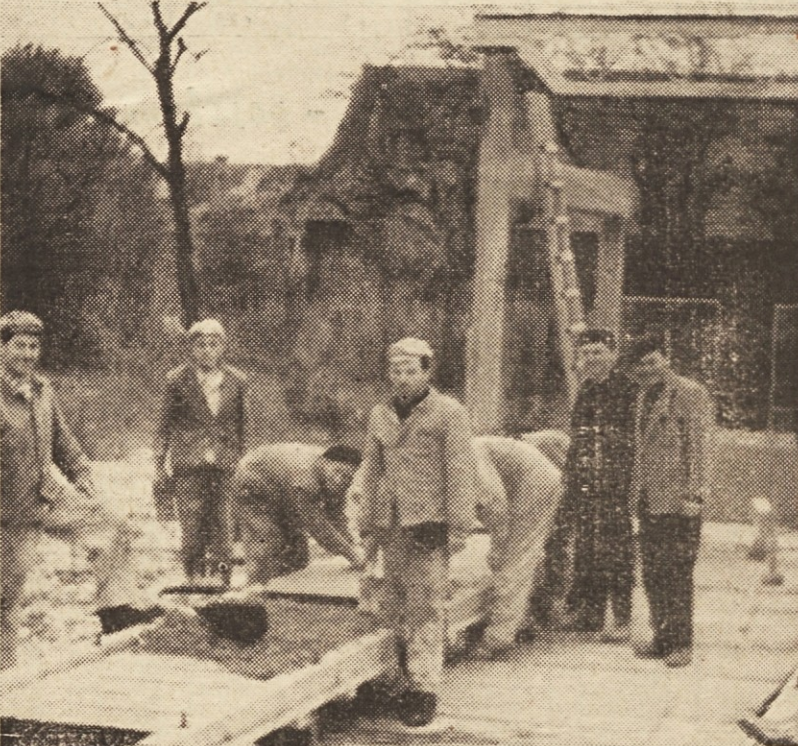
V Mariboru je začela obratovati nova proga za prednapeti beton
