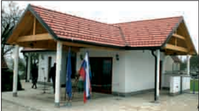
Nova vežica stoji na parceli med vaško šolo in pokopališčem zgradili mrliško vežico.
