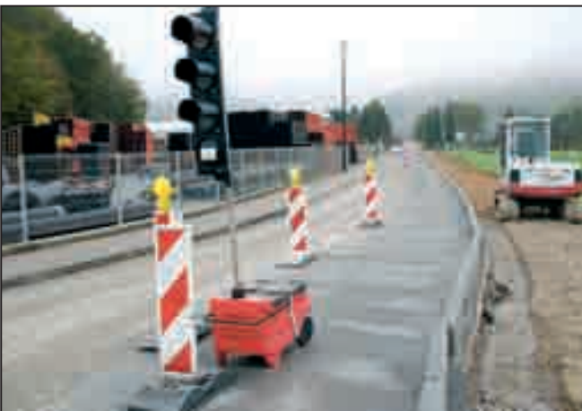
Pogled na gradnjo plačnika ob Vrhniški cesti
