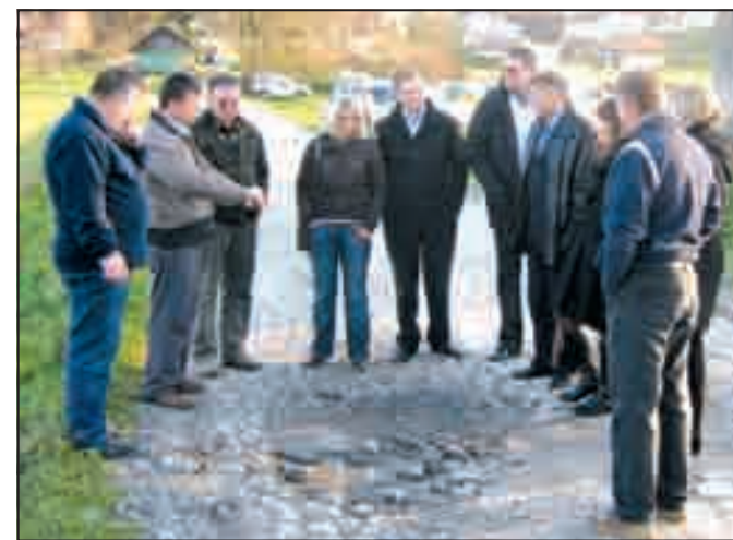
Cesta Bevke-Drenov Grič je v zelo slabem stanju.
