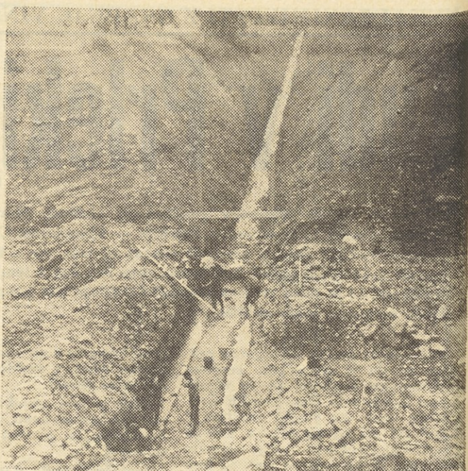
GRADNJA KOPRSKE ŽELEZNICE — Pogled na tale že izkopani propust priča, da so naši delavci le opravili že dober kos dela
