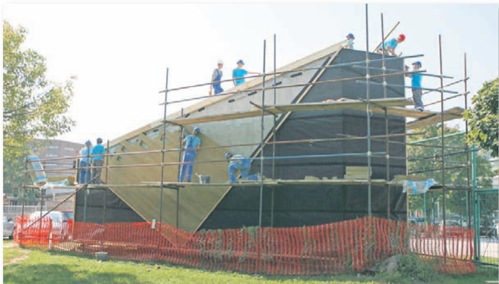
S projektiranjem in izvedbo del na hiši NEVA dijaki pridobivajo znanja nizkoenergijske gradnje.
