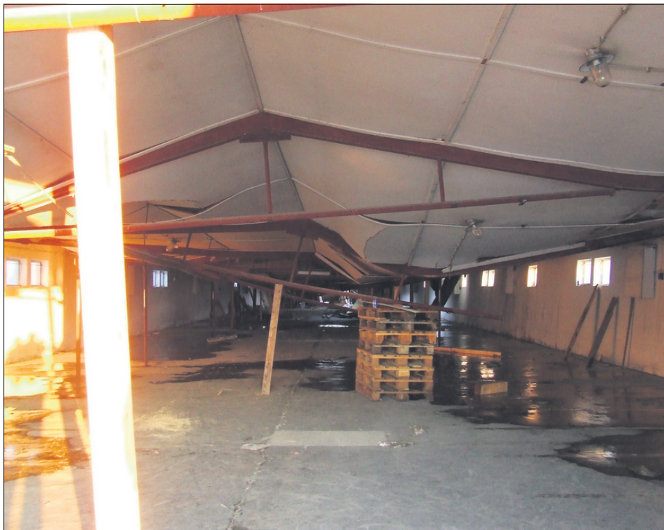
Prizor zvite železne konstrukcije v objektu pri Rakunovih
