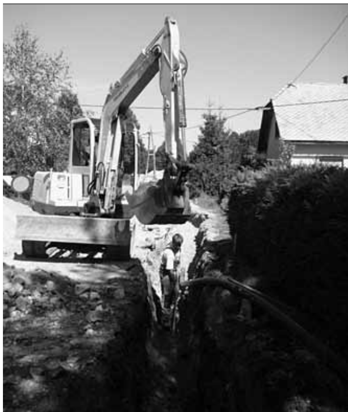
Nadaljujejo se dela pri obnovi vodovodov v Zapotoku.
