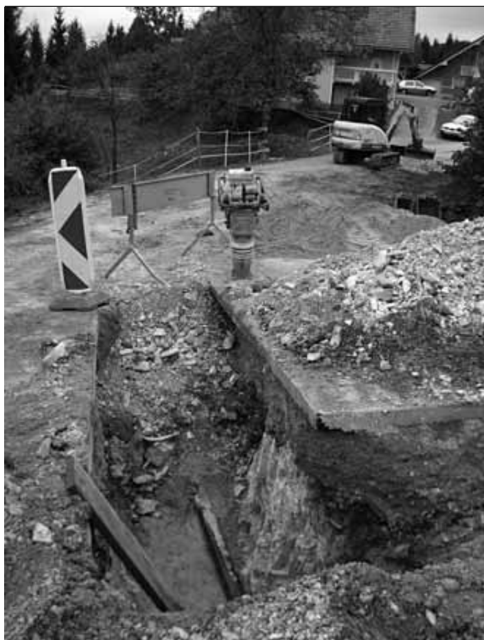
Gradnja vodovoda v Zapotoku
