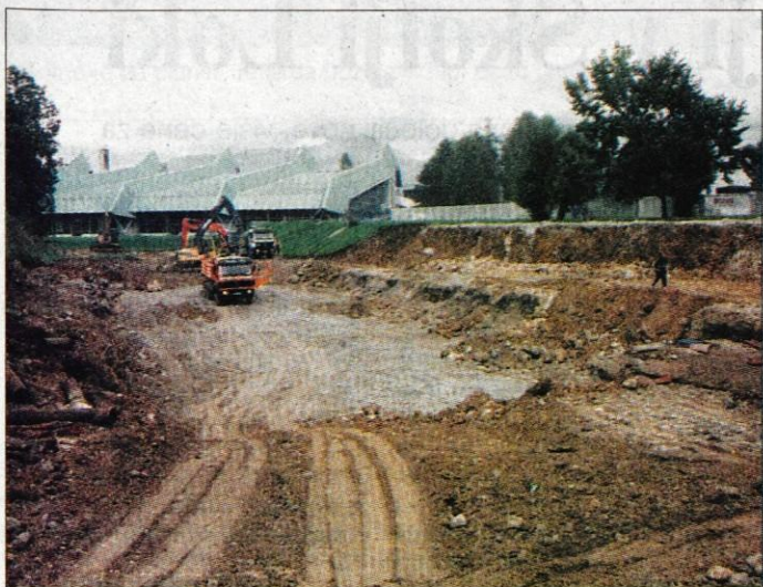
Stari bazen je že podrt, kmalu bodo začeli graditi novega.
