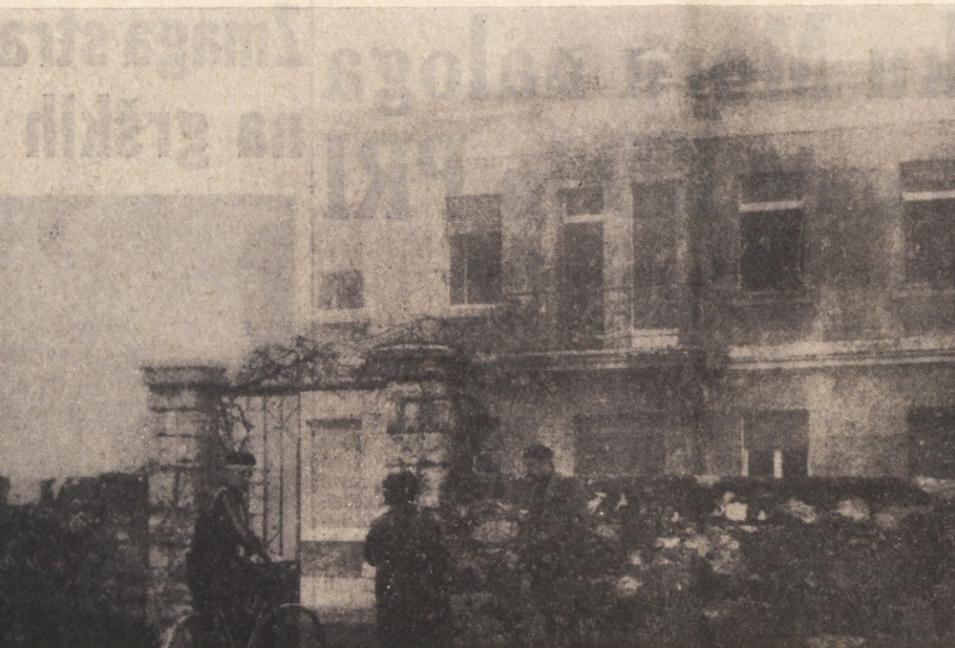
Poslopje proseškega Prosvetnega doma. Streha na desni strani je razkrita
