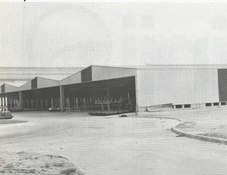
Skladišče anodnih kompletov
