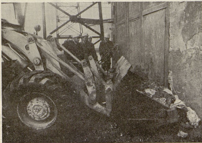
Odstranjevanje ruševin. Foto: Mohorič
