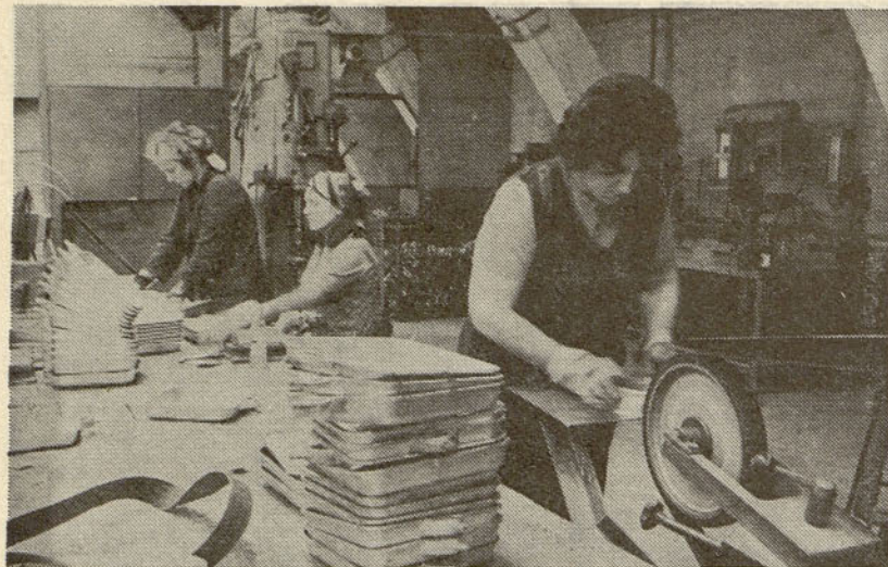
Čiščenje odlitkov. Foto: Mohorič
