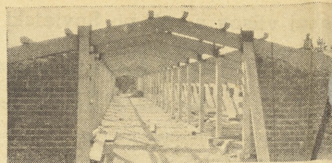
Pred tremi meseci smo v Ptuj začeli graditi štiri velike objekte za perutninarsko farmo v Ptuj. Značilnost objektov je v tem, da so bili projekti izdelani za leseno konstrukcijo. Strokovnjaki iz Maribora pa so jo predelali v betonsko konstrukcijo, kot jo vidite na sliki.
