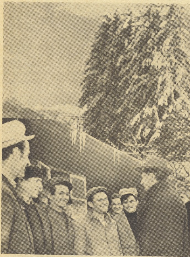
Prvi sneg je pobelil naša gradbišča. Kljub mrazu, so delavci gradbenega vodstva Jesenic veselo razpoloženi.
