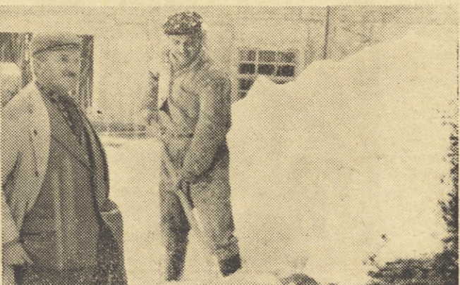
Prvi sneg na enem izmed gradbišč gradbenega vodstva Ljubljana
