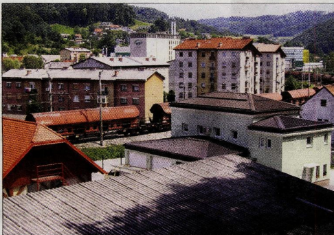
Za postavitve varnostne in protihrupne ograje ob železniški progi na Rinski cesti v Laškem pristojni očitno nimajo ne volje ne sredstev.
