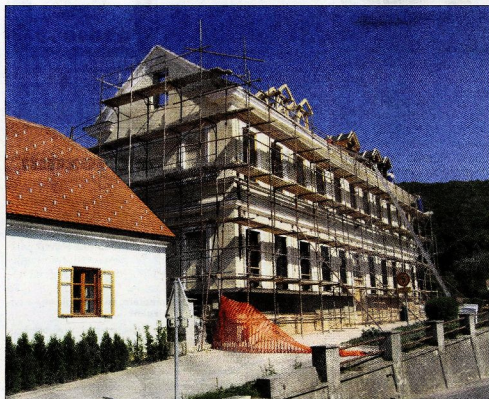
Stara avstrogrška šola v Bistrici ob Sotli je kljubovala zobu časa presenetljivo dolgo. Šola, ki jo je nekaj časa obiskoval Josip Broz Tito, trenutno temeljito obnavljajo.
