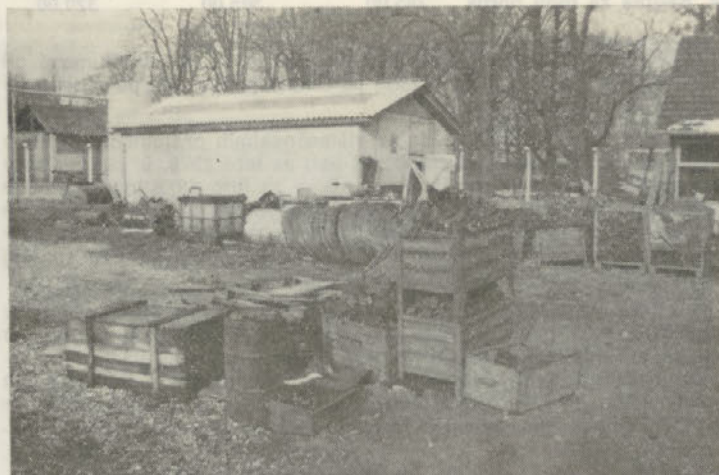
Neurejeno dvorišče — otežkočen dostop v slučaju požara
